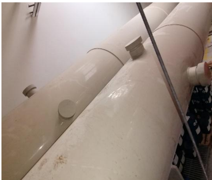
Slika 1: Izpust MMZ14 (levi) in izpust MMZ15 (desni)
